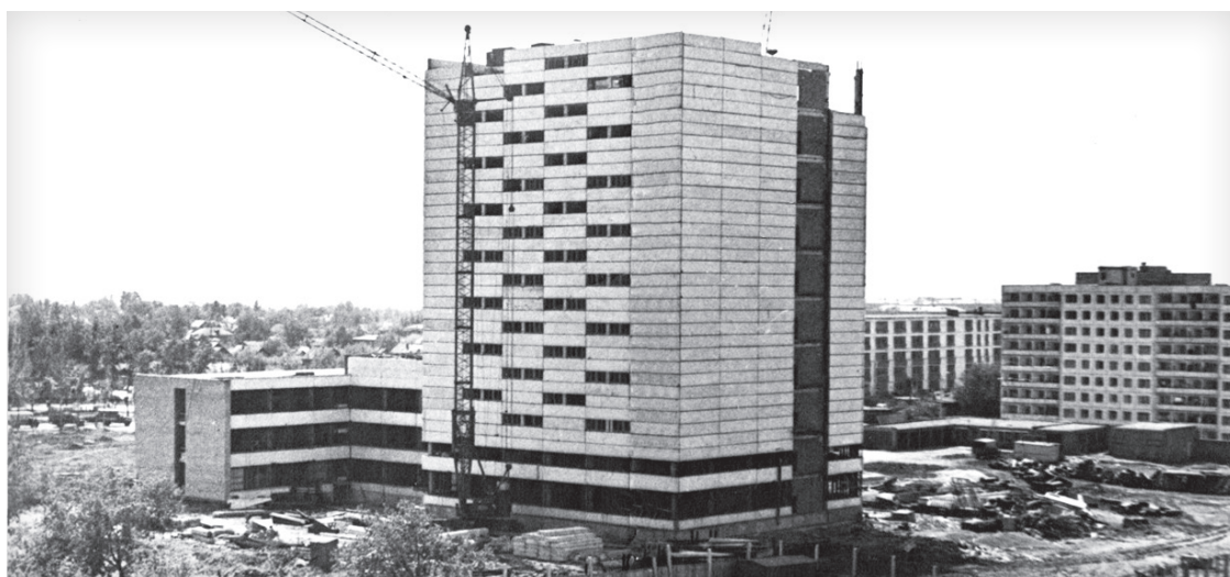
Фото 13. Строительство здания архива в г. Куйбышеве. 1974 г. [33, с. 7]
